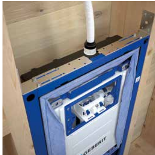
Inbyggnadscisternen ansluts uppifrån med rör-i-rör. Röret fästs säkert och tätt mot säkerhetsboxen.
